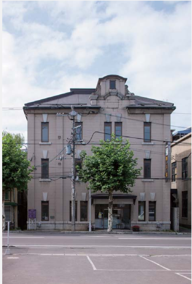
所在地／小樽市入船 1 丁目 1-5 建築年／大正 10 年（1920） 構 造／石造 3 階建
